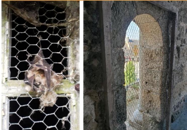
Il est recommandé d'utiliser un grillage en dur afin d'éviter que les ailes ne se coincent ou les blessures. Les pointes métalliques des grillages coupés sont aussi des pièges pour les ailes chauves-souris causant leur déchirure, il convient de ne laisser aucune de ces pointes apparentes.
