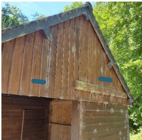
Doublement intérieur en bardage bois et création d'ouverture, les ouvertures peuvent être surmontées d'une petite toiture pour empêcher les problèmes d'infiltration d'eau, boulodrome de Créhen (22)
