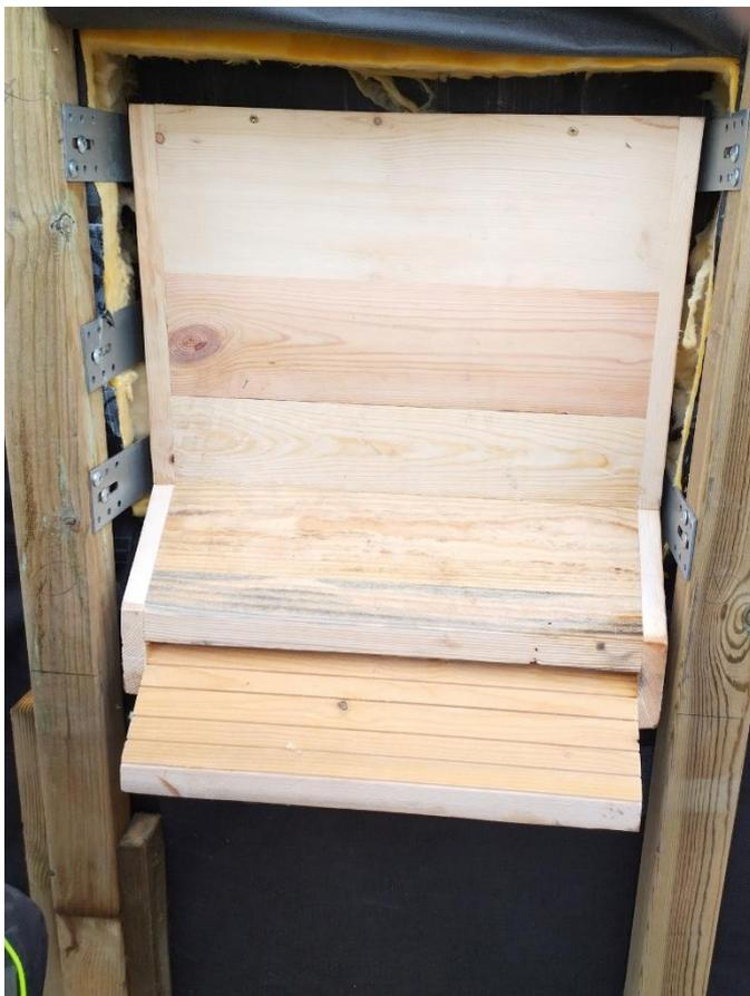
*Photo 10: Intégration d'un nichoir bois dans une nouvelle construction en bardage bois avec isolant sur Crozon – Source Groupe Mammalogique Breton, 2023*
