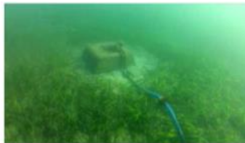
Système de mouillage de Bretagne Plongée : revêtement textile de la ligne (AFB, 2016)
