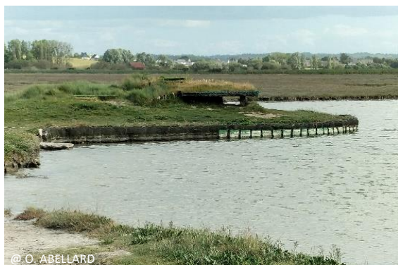
Gabion n°1 – Tertre Corlieu, Lancieux
